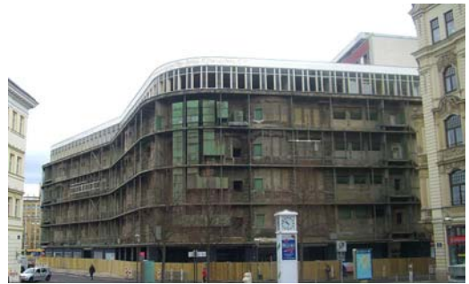
Kaufhaus Brühl 2010, nach Abbau der Alufassade
